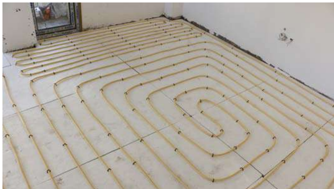
شکل ۳-۷۸: نمونه اجرای گرمایش از کف
