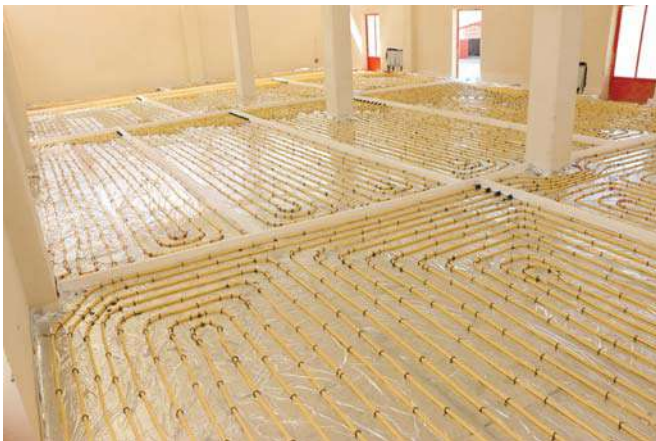
شکل ۳-۷۹: نمونه اجرای گرمایش از کف سوله صنعتی
