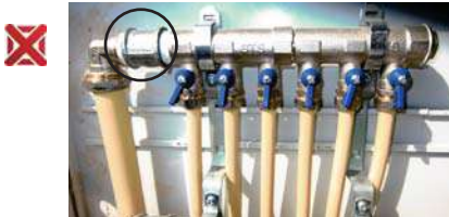
شکل ۴-۲۴: استفاده غلط اتصالات گالوانیزه در کنار اتصالات برنجی
