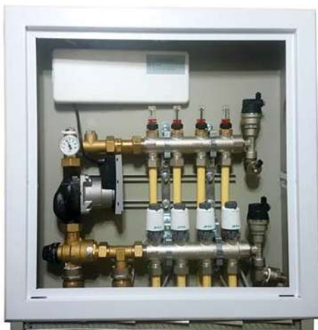
شکل ۳-۵۹: نصب جعبه کلکتور گرمایش از کف و تجهیزات درون آن
