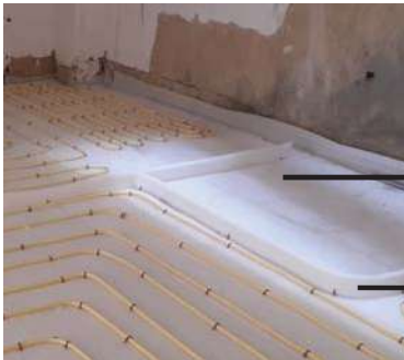
شکل ۳-۶۱: عایق نمودن محیط‌های بدون گرمایش برای جلوگیری از اتلاف حرارت و آسیب دیدن بتن و تجهیزات
