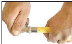
شکل ۴-۱۲: نحوه اجرای اتصالات پرسی
