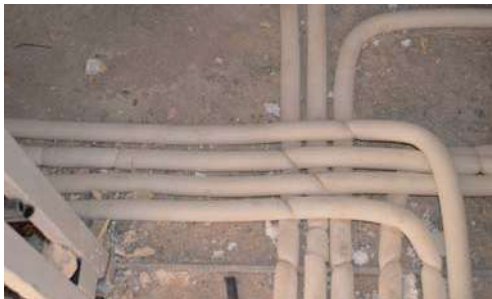
شکل ۴-۱۶: عبور صحیح لوله از ورودی سرویس
