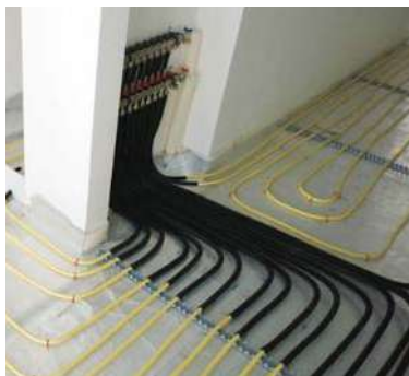
شکل ۳-۶۳: عایق کاری لوله‌های ورودی و لوله‌های گرمایش از کف متصل به کلکتور رفت و برگشت
