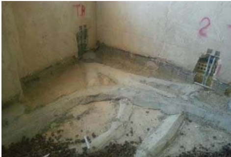
شکل ۴-۳۰: پوشاندن لوله‌ها پس از اتمام تست مجموعه برای جلوگیری از آسیب دیدگی
