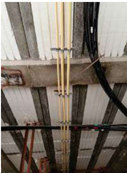
شکل ۴-۱۸: استفاده از بست مناسب برای نگهداری لوله
