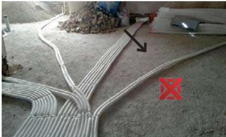
شکل ۴-۱۷: عبور غیر مجاز لوله‌ها به صورت مورب
