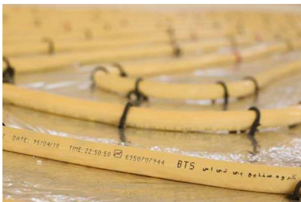
شکل ۳-۸۰: نمونه اجرای لوله گرمایش از کف
