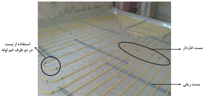
شکل ۳-۶۴: استفاده از بست‌های ریلی و بست خاردار در اجرای لوله سیستم گرمایش از کف
