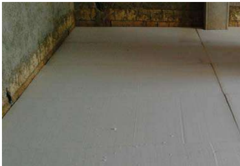
شکل ۳-۱۸: نمونه‌ای از عایق کاری کف
