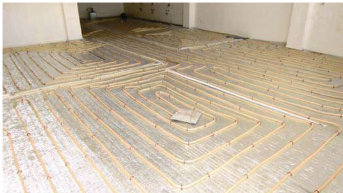
شکل ۳-۷۷: نمونه اجرای گرمایش از کف
